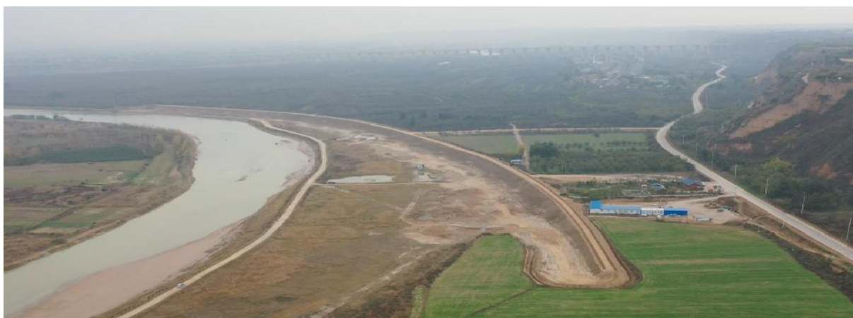
图 2.2-4 工程区已建太平堡工程现状图
